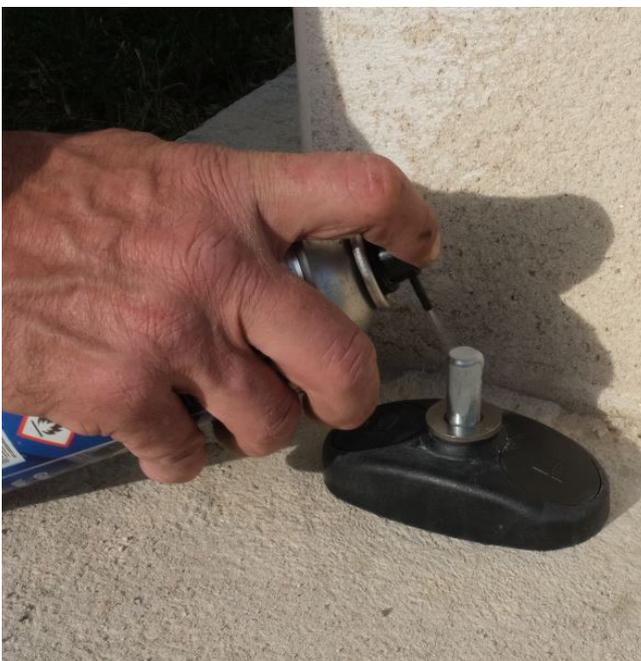
Appliquer de la graisse teflon sur les axes des crapaudines.
