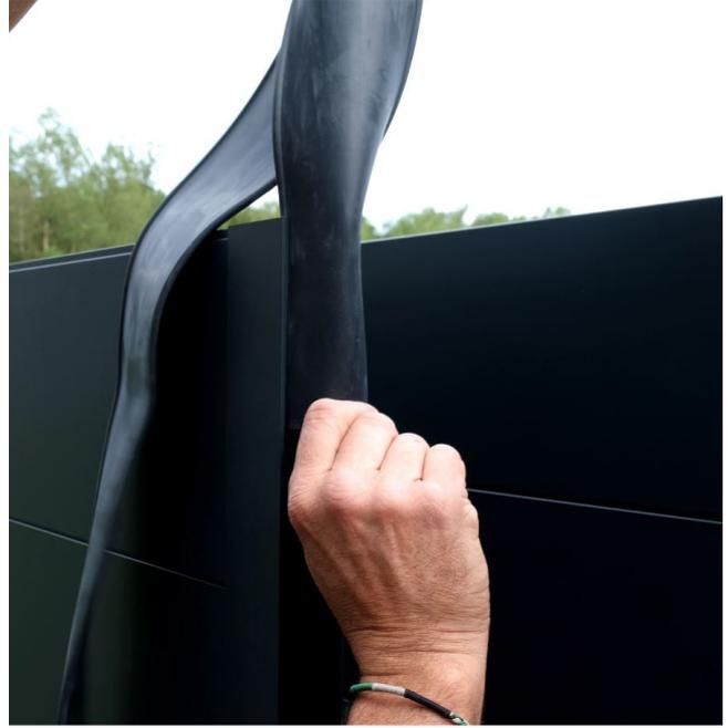
Bande passive à insérer dans le montant du portail
